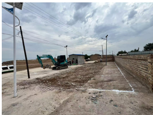
图 2-12 修建村委会地基
