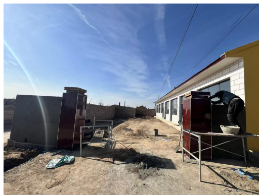
图 2-13 村委会基建施工
