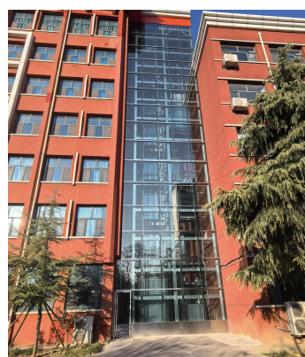
图 6-16 加装电梯工程
