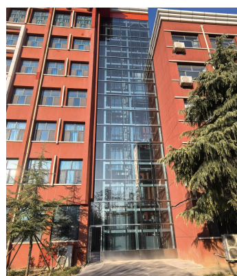
图 6-16 加装电梯工程
